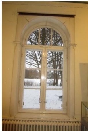
Abb. 4 Fenster mit Blendrahmen
