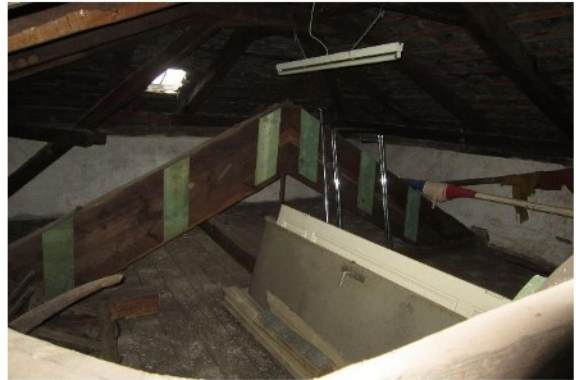
Abb. 17 Hängeböcke im Dachgeschoss
