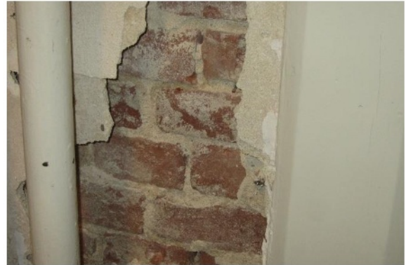
Abb. 34 Putzschäden
