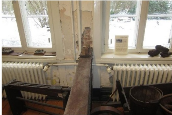
Abb. 33 Putzschäden Südaußenwand
