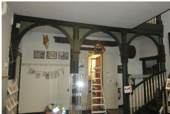
Abb. 8 Vier Holzstützen der Deckenabfangung
