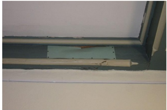
Abb. 19 Der Schaden ist durch Platte verdeckt
