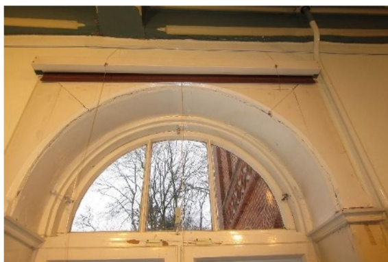
Abb. 6 Risse im Blendrahmen
