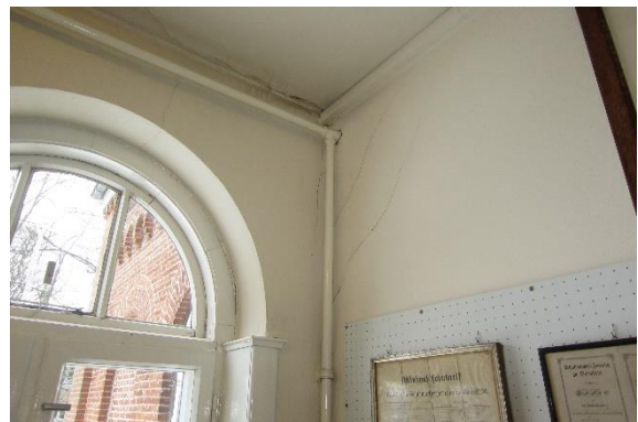
Abb. 56 Wasserfleck und Risse in der Innenwand
