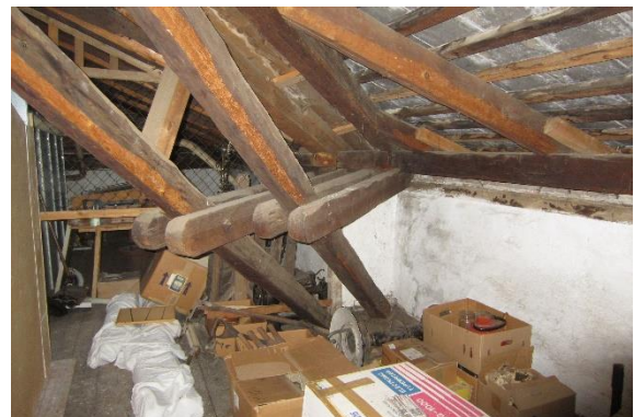
Abb. 76 Grat- und Kehlkonstruktion
