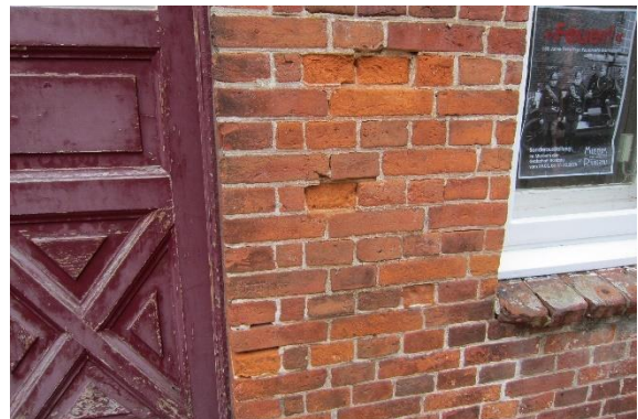
Abb. 92 Fehlstellen in Fugen und Stein
