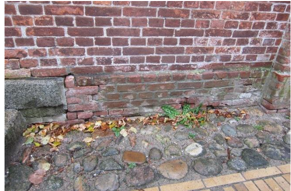
Abb. 90 Fehlstellen im Sockelmauerwerk
