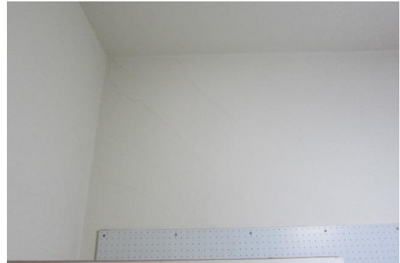
Abb. 58 Risse in Innenleichtwand
