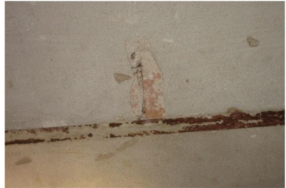
Abb. 38 Fehlstelle in Kappendecke
