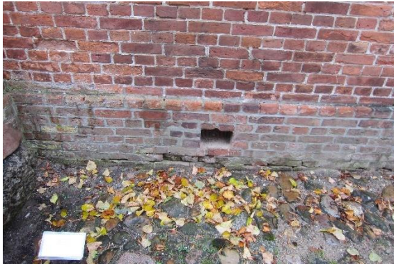
Abb. 89 Fehlstellen im Sockelmauerwerk
