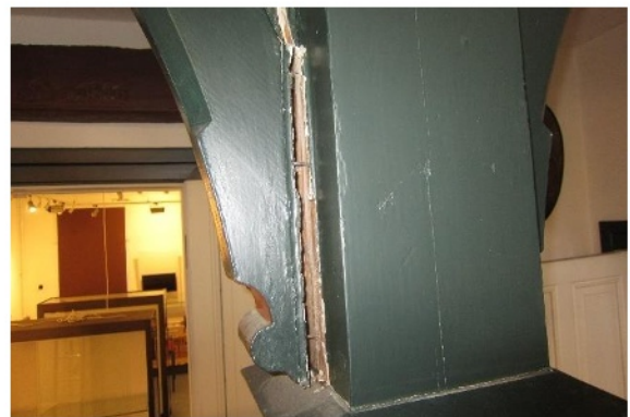
Abb. 11 Fuge an runden Kopfband
