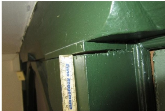
Abb. 41 Stützenkopf mit Füllholz
