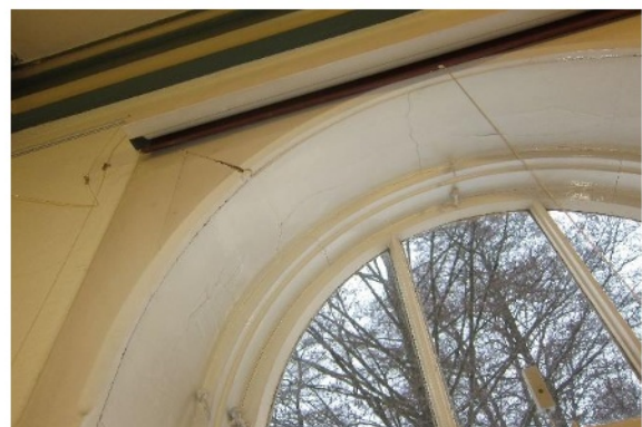
Abb. 7 Risse im Blendrahmen
