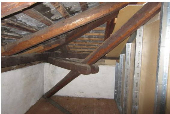
Abb. 75 Gratkonstruktion
