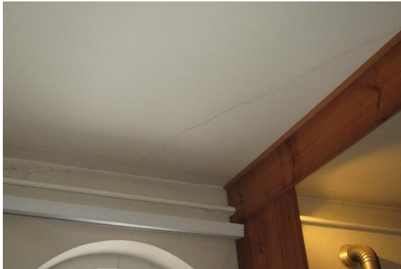
Abb. 53 Riss Decke und Fenstersturz
