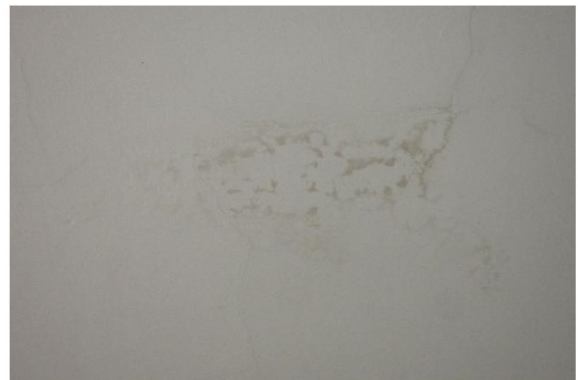
Abb. 48 Wasserfleck in Decke
