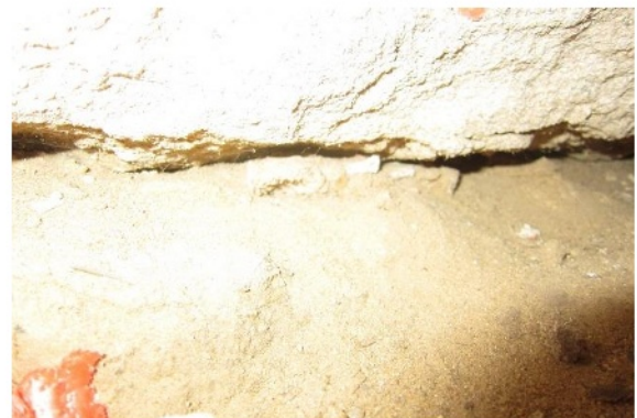
Abb. 15 Sandauffüllung und Estrich
