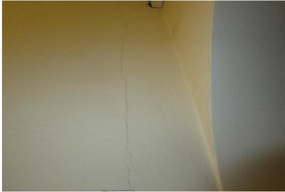
Abb. 49 Riss in Leichtwand im Anschluss der Massivwand
