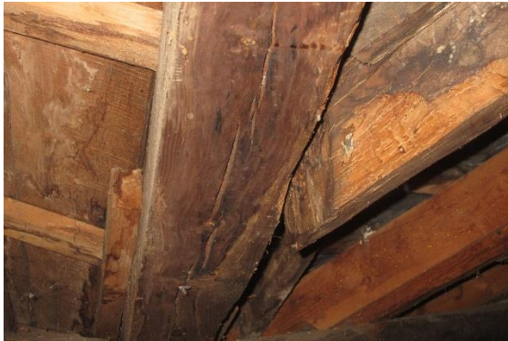
Abb. 84 Fuge im Schifter
