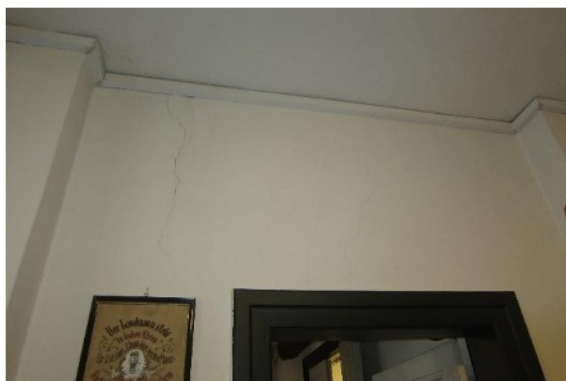
Abb. 31 Risse in der Wand zum Flur
