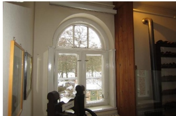
Abb. 5 Fenster ohne Blendrahmen
