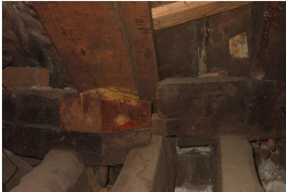
Abb. 78 Fußauflager Kehlsparren
