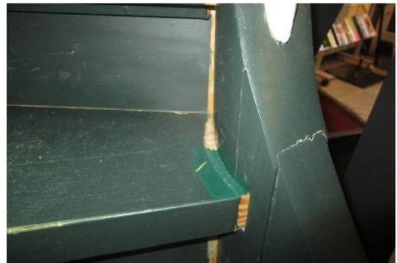
Abb. 9 Treppenstufen rutscht aus der Treppenwange
