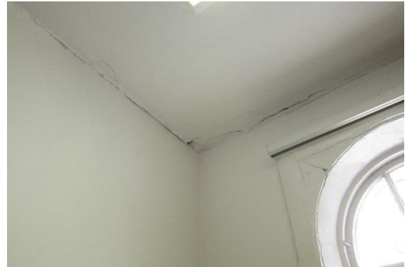
Abb. 62 Decken Riss in Raumecke
