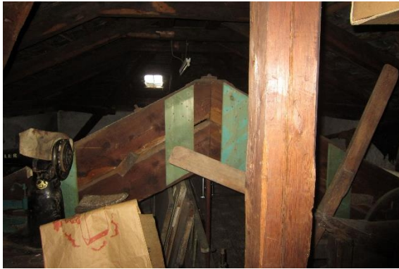
Abb. 81 Sprengwerk
