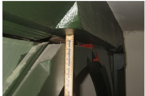
Abb. 42 Fuge in Kopfbandanschluss
