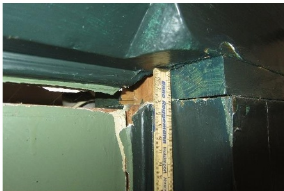
Abb. 10 Fuge am Stützenkopf
