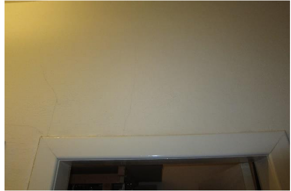
Abb. 50 Risse im Türbereich der Leichtwand
